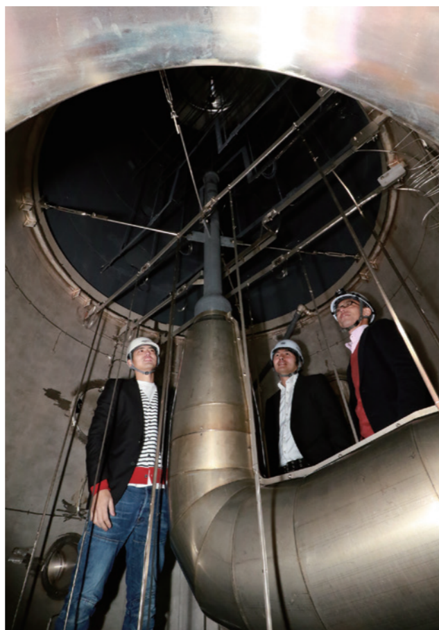
CIGMA内部。中央にあるのは高温の蒸気を送り込むための配管。
