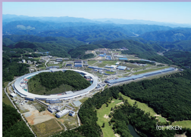
※ SPring-8(スプリングエイト、Super Photon ring-8 GeV)とは、兵庫県の播磨科学公園都市にある世界最高性能の放射光を生み出すことができる大型放射光施設です。電子を光とほぼ等しい速度まで加速し、磁石によって進行方向を曲げて発生させた放射光を使って、様々な研究が行われています。
